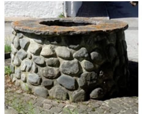
*Der Tiefbrunnen in Unterperfuss (außer Betrieb) weist darauf hin, wie das Wasser aus der Tiefe des Inn-Grundwasserstandes heraufbefördert wurde. So wird es im Unterdorf von Völs passiert sein. Die Brunnen waren überdacht und mit einer Winde zum Hochziehen der Eimer versehen.*
